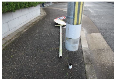
倒壊した路側標識
