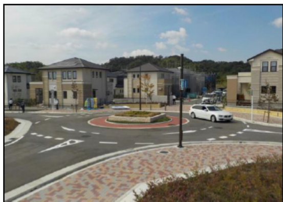
県内に設置された「ラウンドアバウト」
