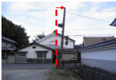
傾斜した信号柱
