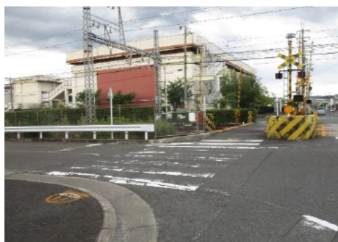
摩耗した横断歩道・停止線
